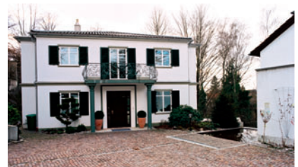
05 C Im abgesenkten Zustand verrät nichts, dass unter dem Zierteich 2 Autos parken. Once lowered into the ground position nothing reveals that there is parking space for 2 cars above each other under the pond.
